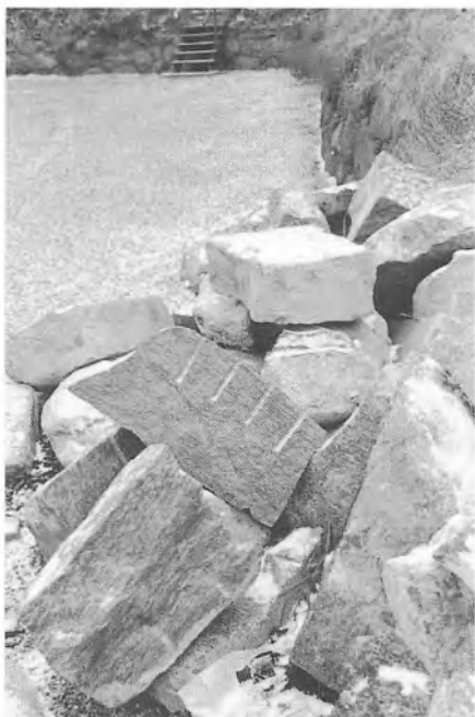
Kvaderne på Kronborgs fæstningsareal med spor efter moderne kløvning med jernkiler og boremaskine. Lone Hvass fot. 1999.
