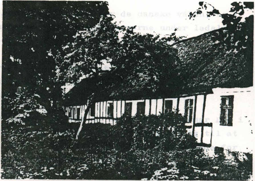
Hessel. Hovedbygningens vestside mod haven.
