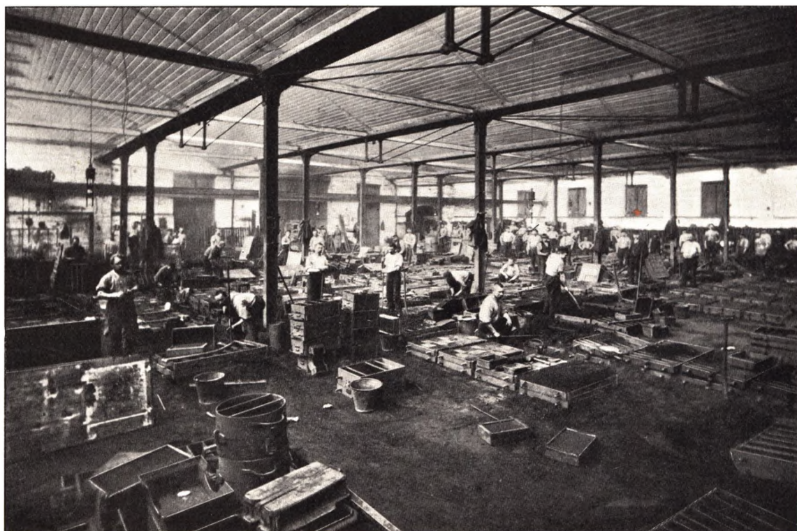
STØBERIET PAA FABRIK B
