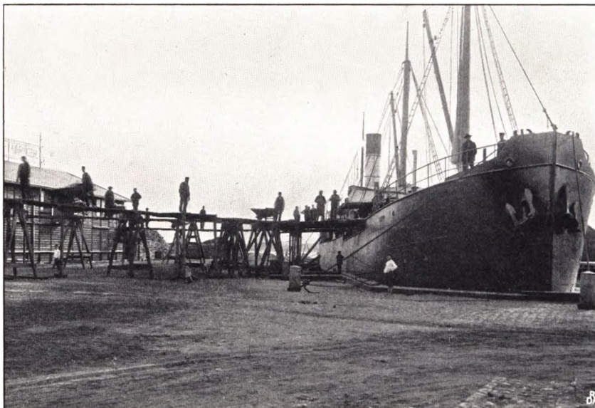
LOSNING AF EN DAMPER MED SALTSTEN
