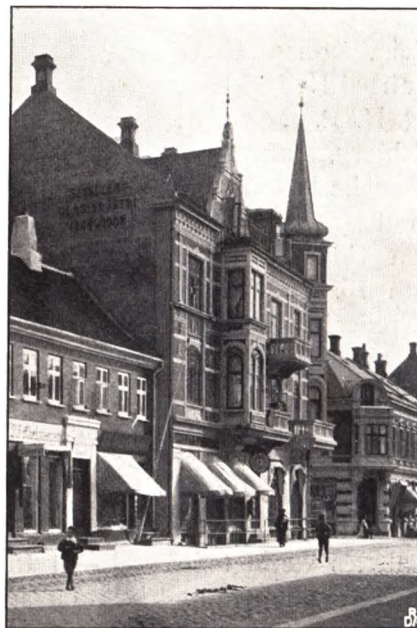
FAÇADE AF EJENDOMMEN
