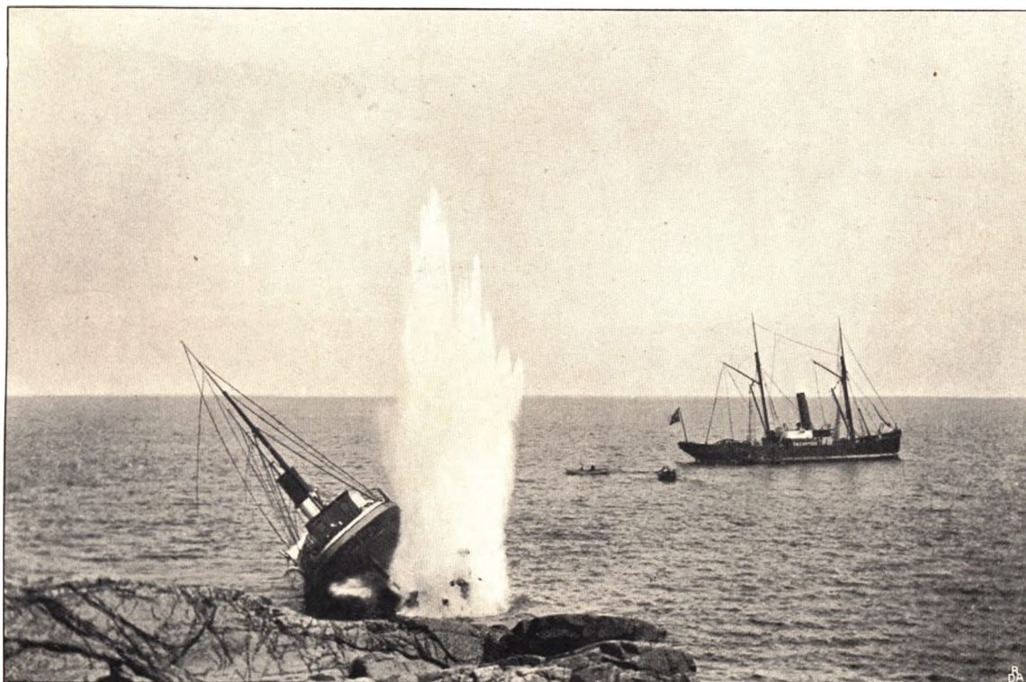
ANVENDELSE AF DYNAMITSPRÆNGNING VED BJERGNING AF DAMPSKIBET »M. DAVIDSEN«, GRUNDSTØDT VED BORNHOLM DEN 24. OKTOBER 1901
