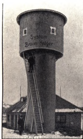
15000 LITER PR. TIME STOCKHOLM—VESTERÅS- BERGSLAGEN-JÄRNVÄG, SUNDBYBERG SVERIGE
