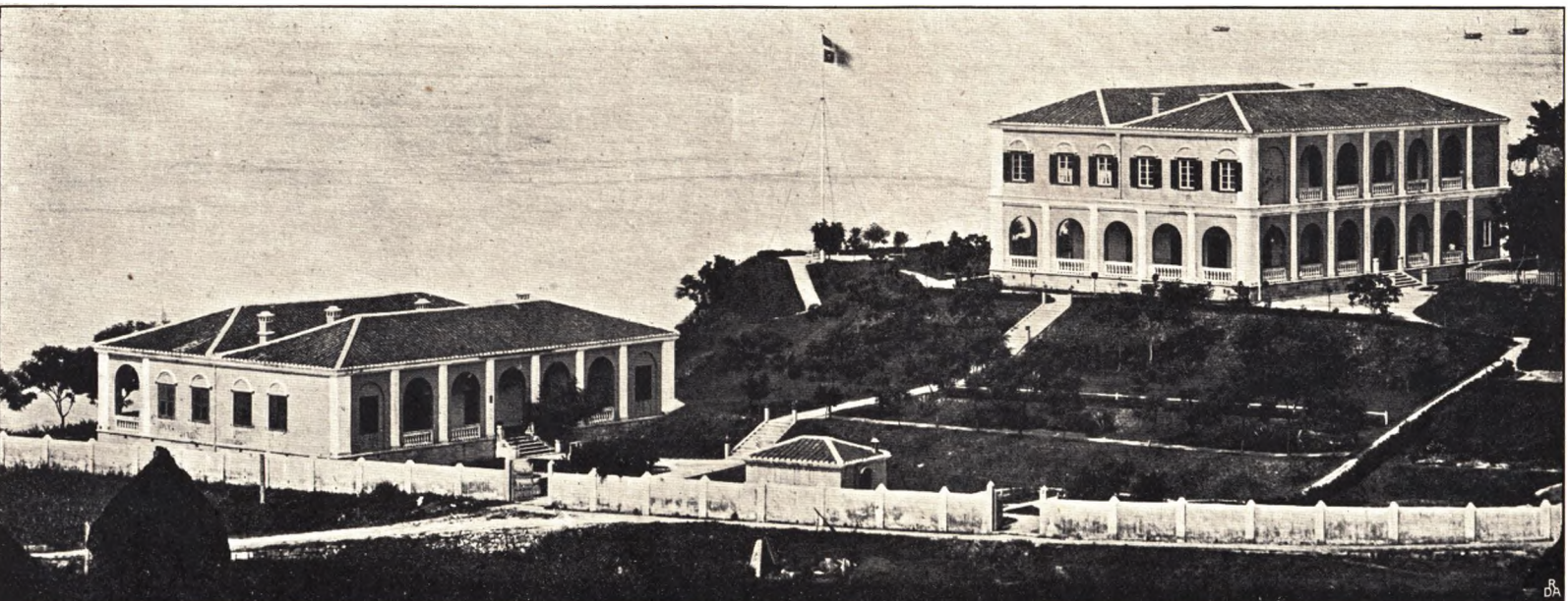
SELSKABETS STATIONSBYGNING OG VAANINGSHUS I AMOY
