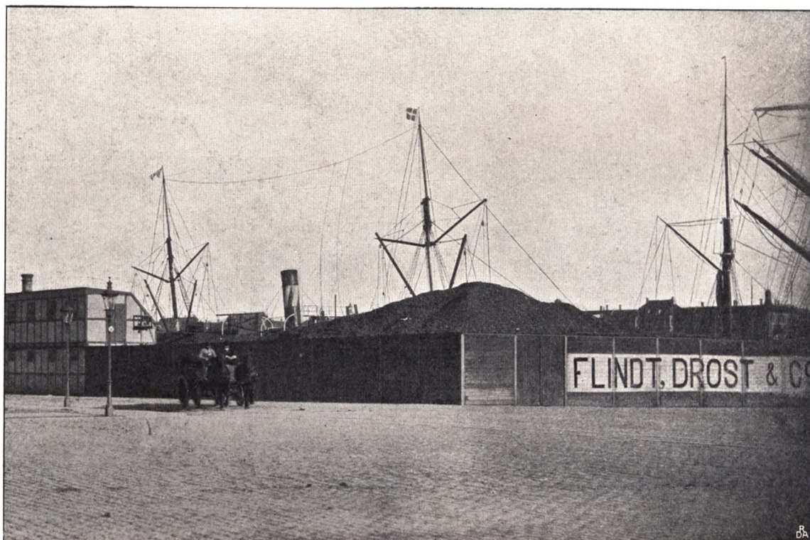
OPLAGSPLADSEN VED KAJGADE
