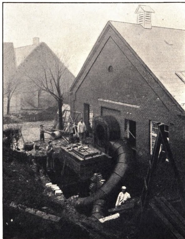
TRYKLUFTS OPVARMNINGS- OG VENTILATIONSANLÆG CARL ALLERS ETABLISSEMENT
