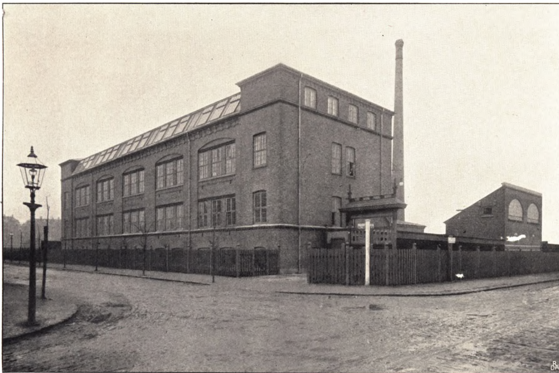
FABRIKSBYGNINGEN I KJØBENHAVN
