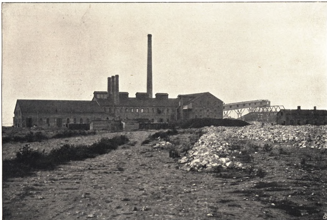
CEMENTFABRIK I KLAGSHAMN, SVERIGE, BYGGET AF F. L. SMIDTH & CO.
