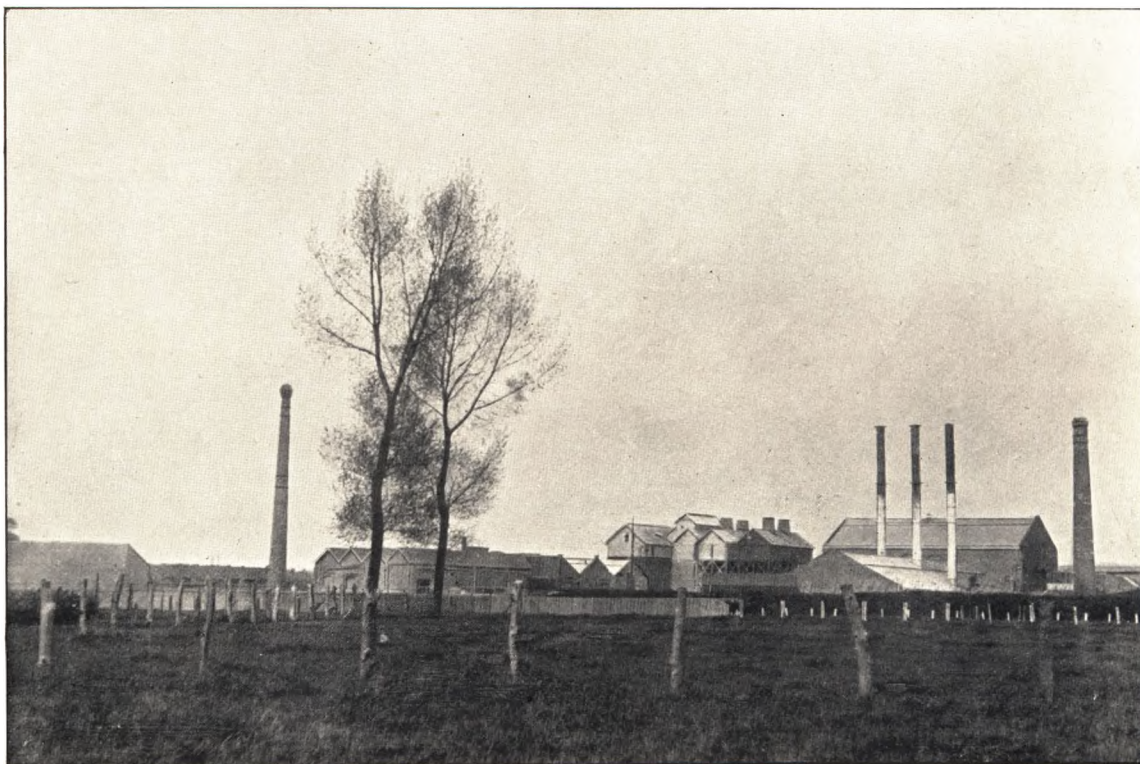
CEMENTFABRIK I HAUBOURDIN, FRANKRIG, BYGGET AF F. L. SMIDTH & CO.
