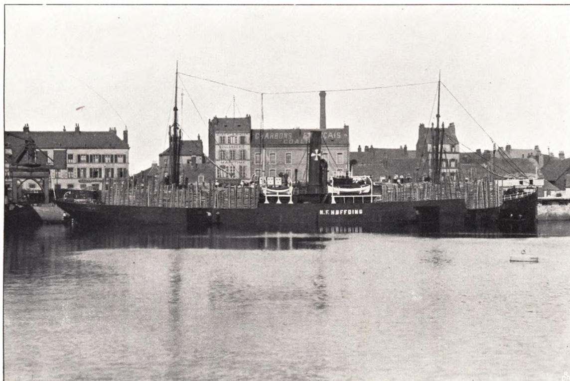
S/S »N. F. HØFFDING« UNDER LOSNING I BOULOGNE
