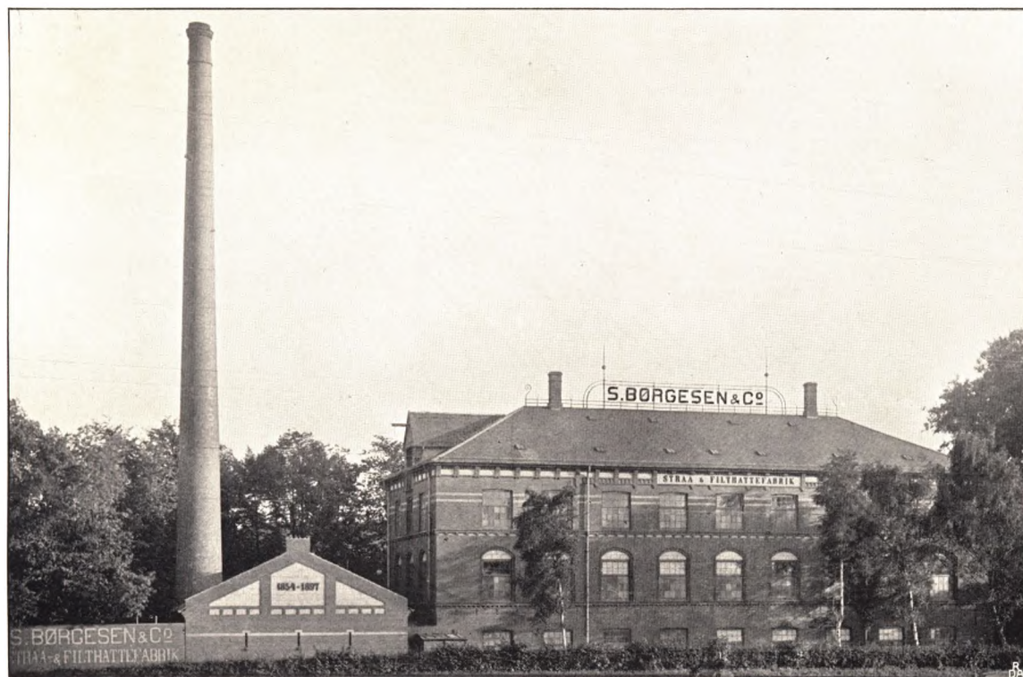
FABRIKEN PAA LAMPEVEJ VED FREDERIKSBERG STATION
