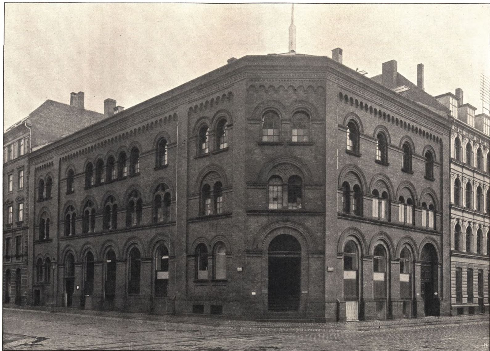
FABRIK- OG KONTORBYGNINGEN
