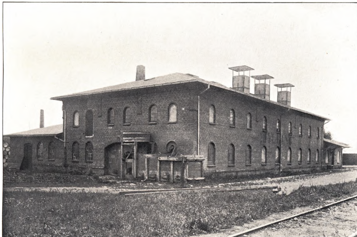
CICHORIETØRRERIET »JYLLAND«, KOLDING
