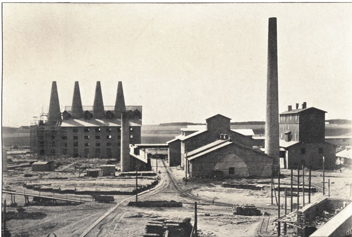
CEMENTFABRIK I KUNDA, RUSLAND, BYGGET AF F. L. SMIDTH & CO.
