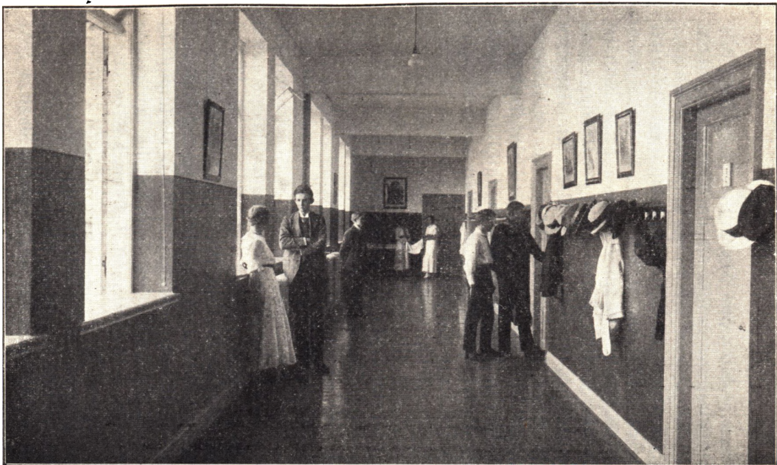
Korridoren i den ny Bygning.
