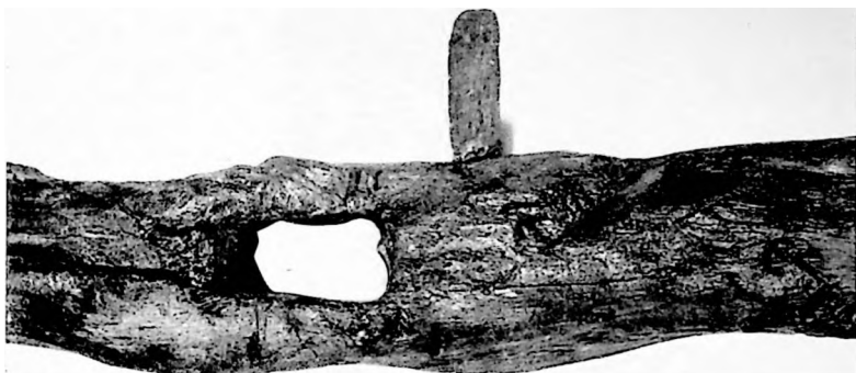
5 Taphul til langjern set fra åsens underside. Borehuller i forkanten. H. V. foto.
