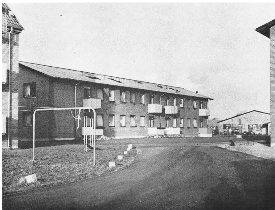
Ved Arbejderbo« er en ny sektion færdig, og »Lejerbo« (herunder) forbereder også nyt byggeri.
