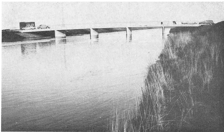
Ved Albæk har landskabet helt skiftet karakter. Det gamle åløb er sat ud af funktion, og det nye åløb er ledet ind under den nye Albæk bro, en bred og smuk vejbro, der ses herover.
