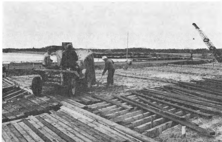
Her støbes mellem brobjælkerne på den nye vejbro mellem Skjern og Tarm. Snart begynder støbningen af selve brodækket.
