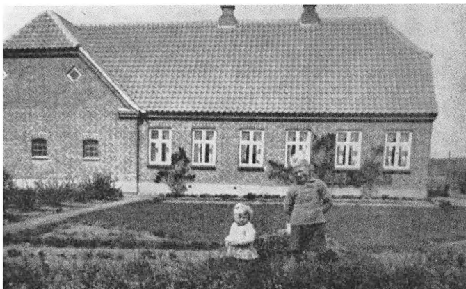
Nogle af ejendommene havde fritliggende stuehus, men de fleste bestod som Balle Nielsens her af to sammenbyggede længer. Billedet viser facaden mod syd. På nordsiden var der to fordøre. Huset rummede i alt tre stuer, køkken, spisekammer, bryggers og forstue. Fra køkkenet var der nedgang til en god frostfri kælder. Balle Nielsens børn, Kirsten og Anders, leger ubekymret i haven, trods det at deres hjem som alle danske landmandshjem i det år, 1932, måtte lide under landbrugskrisen.
