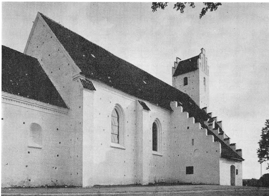
Dråby kirke efter restaureringen. Nordsiden med det genåbnede våbenhus. Poul Pedersen fot.
