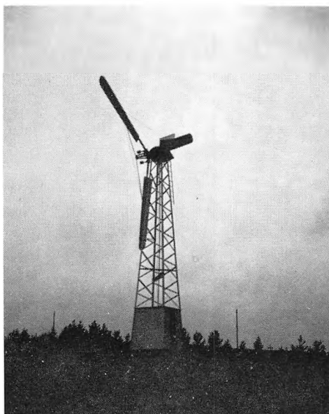
Fig. 2. Varmemølle fungerende efter generatorprincippet, J. T. H. Myhre, Stjær ved Harlev (se note 1).
