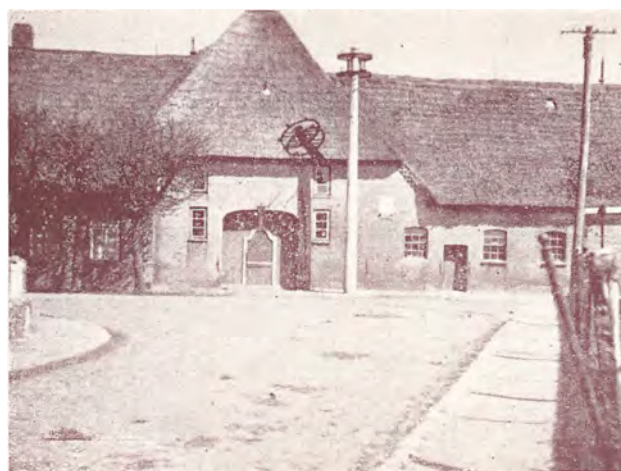
26. Fra Erfde: Til Saksergaarden som Kærne er bygget en Stue- og en Staldfløj. Læg Mærke til, at Indgangen stadig fører gennem Loen!
