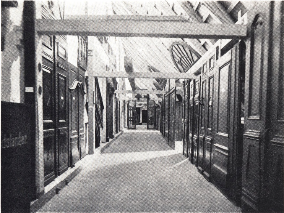
Loftskorridor med porte og gadedøre 1916.
