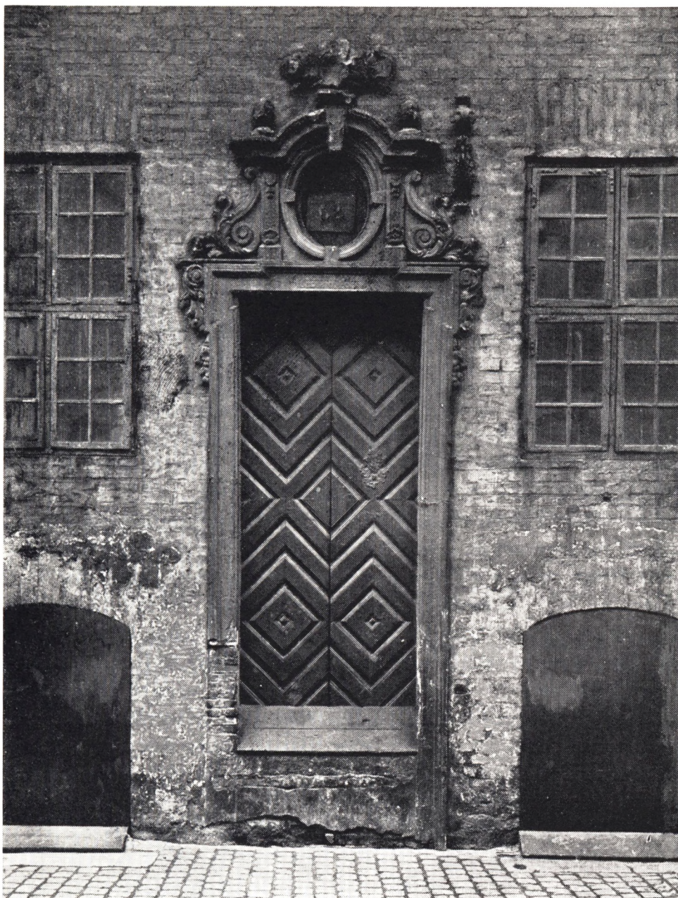
Portal fra 1729. Dronningensgade 68. Nedtaget 1932.
