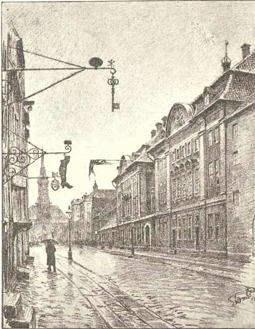
Ostindisk Kompagnis Bygninger i Strandgade.
