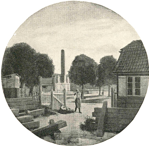
Tømmerhandler Collstrups Plads ved Frihedsstøtten 1814.
