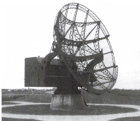
En af den type radar, som stod på Mammut-anlægget på Rømø for at overvåge flytrafikken over Nordsøen.
