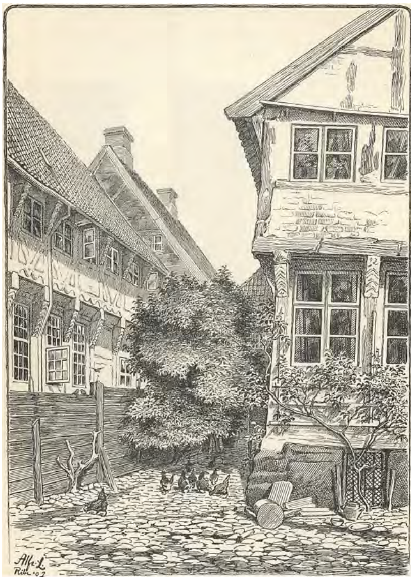
Bindingsværkshuse, Mellemdammen Matr. 11 og 12; Sidelængerne.
