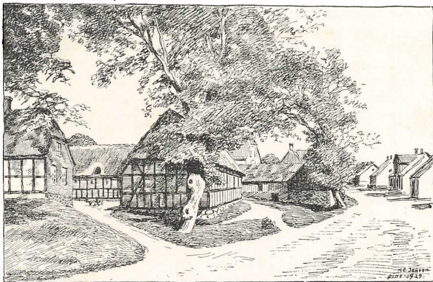
„Herregaarden“ i 1929. Gavlen ombygget og Soklen sat i tilhuggen Kamp.
