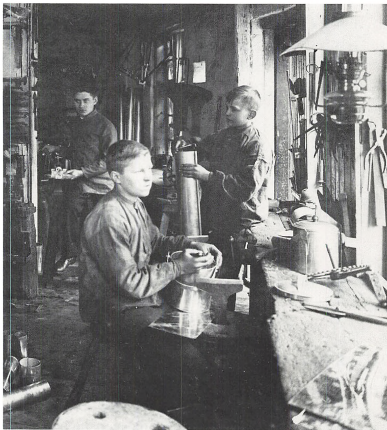
Læredrengene ved Julius Jensen Dalsborgs blikkenslagerværksted i Sudegade 16, 1905.
