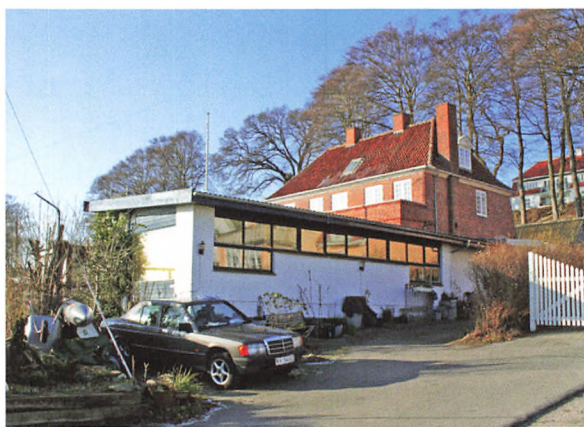
Bygningen er opført i 1969 og anvendtes i de første fem år til købmandsforretning. Nu indrettet til beboelse. Foto 2009.
