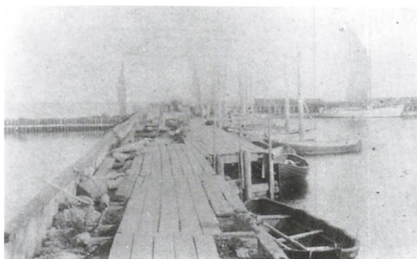
Nordre mole som den så ud omkring 1890. Det hele var endnu meget primitivt med planker, der blot var fastgjort på en enkelt træramme.
