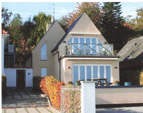
Huset er siden udmatrikuleringen i 1997 udvidet med en tilbygning mod øst. (Foto: okt. 2008)
