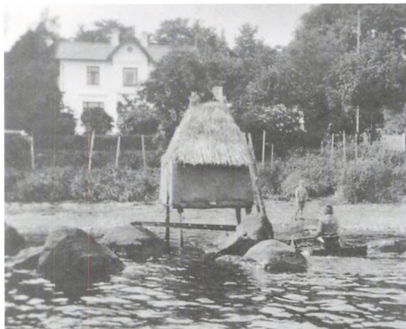
Ud for "Skellebækhus" byggede Thorvald Antvorskovs søn, Frede, i 1920'erne denne hytte ude i vandet. Den holdt dog ikke til den næste storm, hvor gangbroen blev skyllet væk og den besøgende landligger-søn måtte reddes i land - efterfulgt af kraftige formaninger! I baggrunden t.v. ses "Villa Snekkersten", Strandvejen 114.
