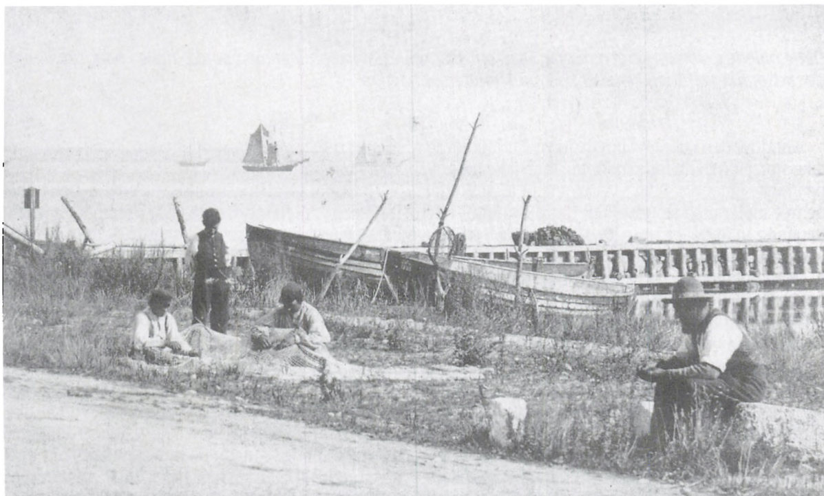
Et af de ældste billeder af det nye havneanlæg. Billedet viser den nordre mole. På stejlebakken ud for selve havnen arbejder et par fiskere med deres net. Fotografiet er fra omkring 1881.
