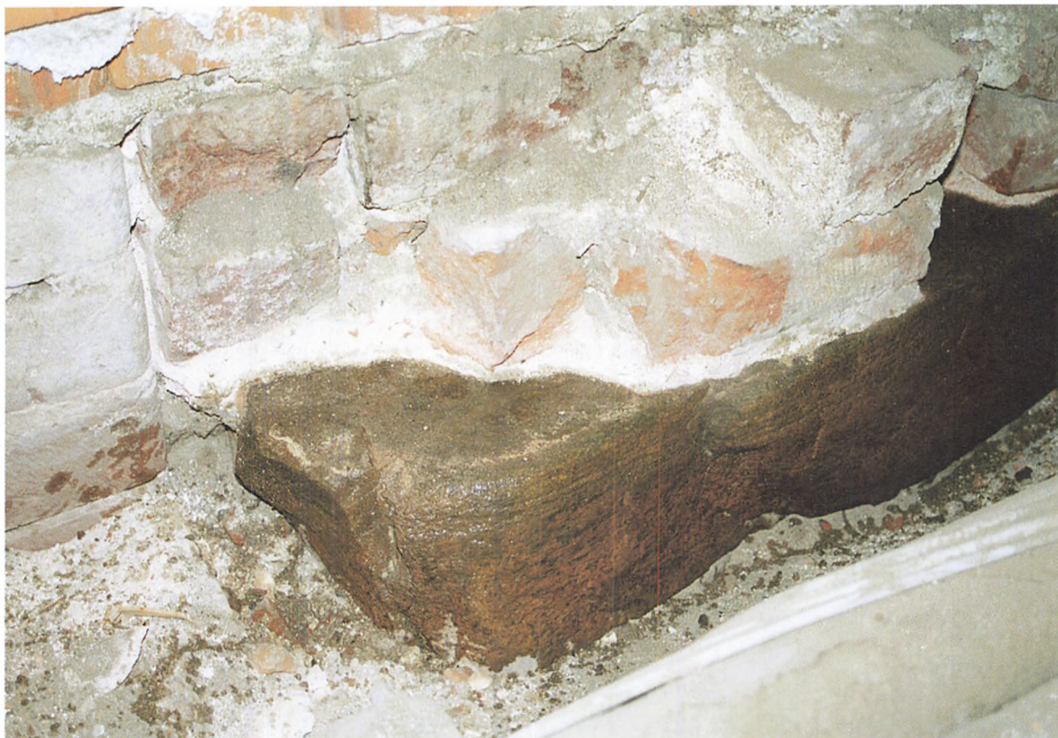
Tærskelstenen til den tidligere kvindedør i nordre sideskib, der afløstes af tårnindgangen i forbindelse med opførelsen af Oxes kapel. Den befinder sig under den nuværende indgang fra kirken til Oxes kapel. (Søren Larsen fot.)
