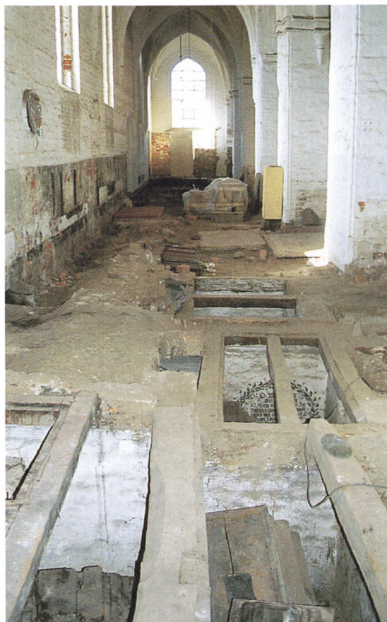
Da bræddegulvet under restaureringen blev fjernet, kunne alle gravkældrene blottes, som det ses af dette billede fra søndre sideskib. En del gravkældre var forsynet med lemme, således at nye begravelser i kældrene bekvemt kunne finde sted. En fals i rammebjælkerne sikrer, at lemme ligger plant med gulvet.
