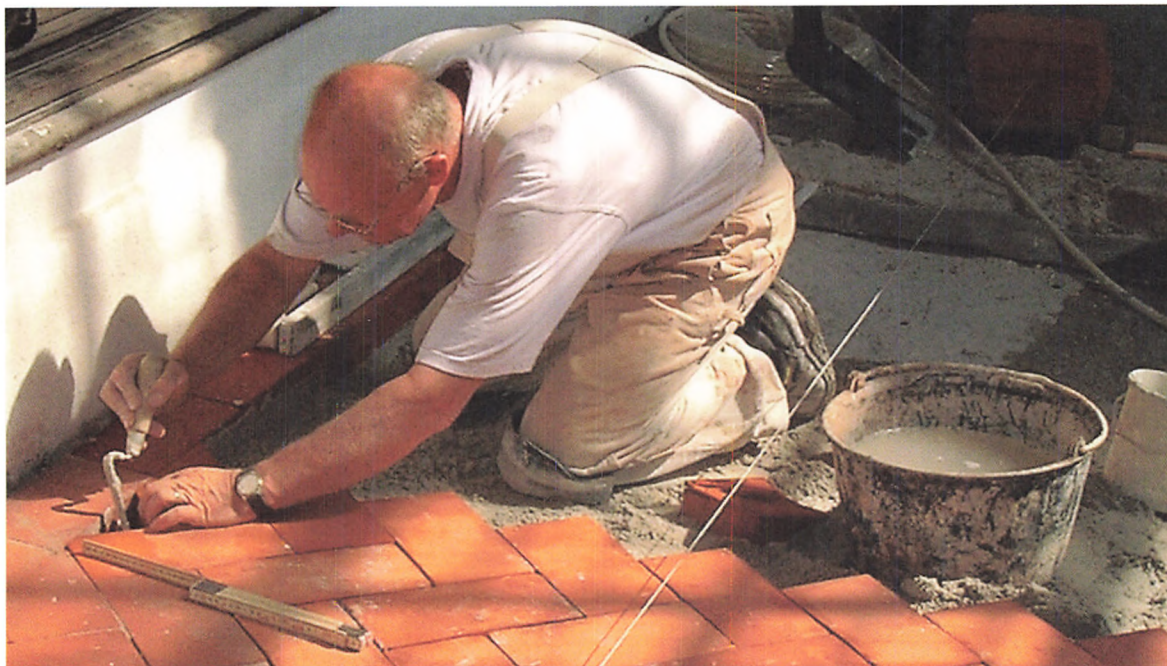
Det nye teglgulv lægges i sildebensforbandt i hydraulisk mørtel med knasfuge, så tæt som muligt. (Søren Larsen fot.)
