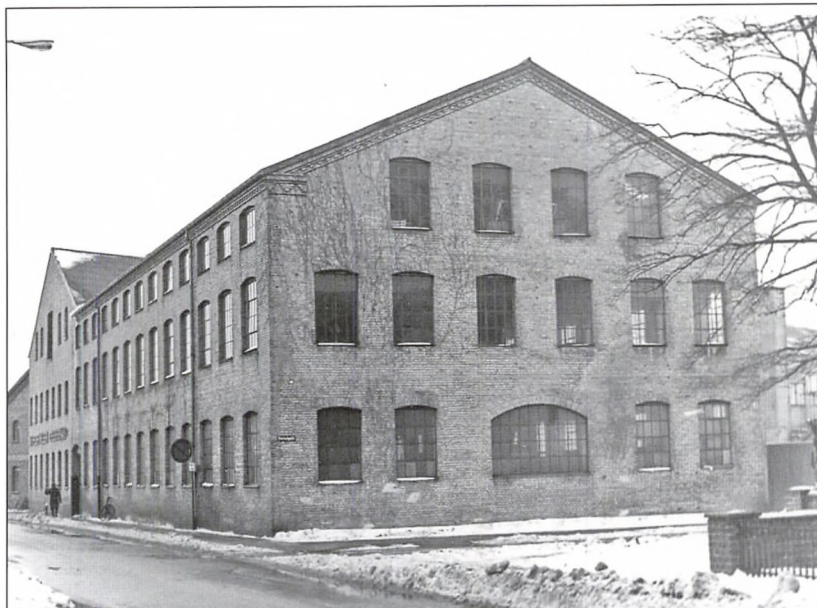
Figur 11. Pedershaab Maskinfabrik, afdeling for stålvinduer og ståldøre, bygget 1931.
