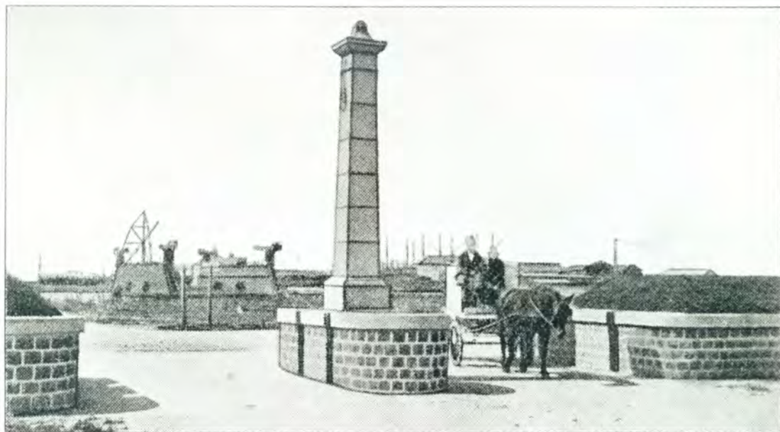
Den monumentale Indkørsel til Rødby Havn.
