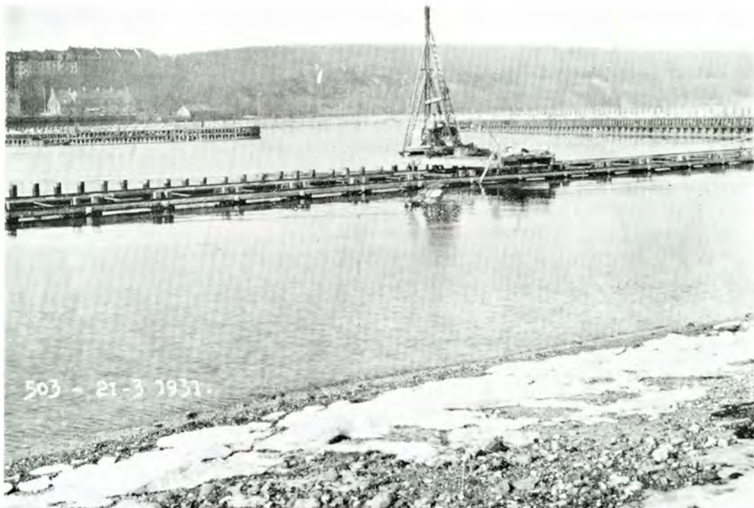
Bolværk i den nye Lystbaadehavn, Marts 1931.
