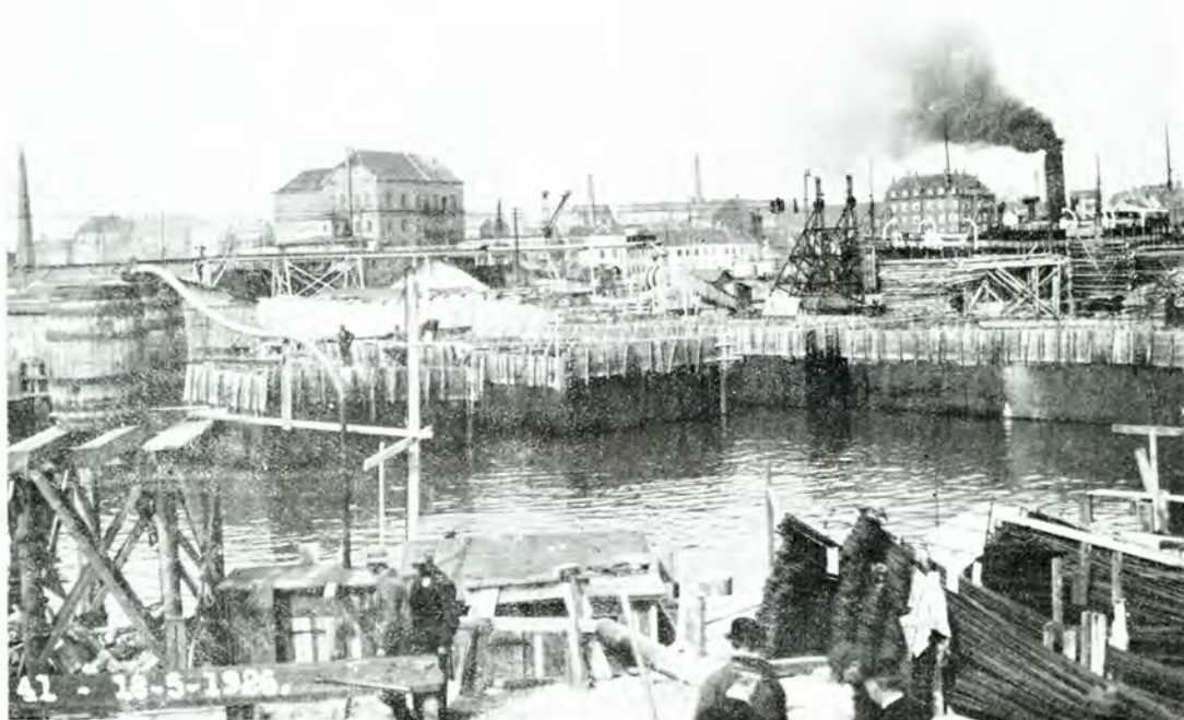
Sænkekasser i Dokken til Østre Moles Bygning.
