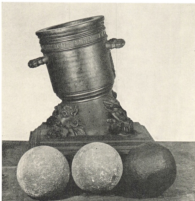
Fig. 6. Metal-Fodmorter paa 100 Pd. Sten. Støbt af Clavs von Dam 1643. (Nr. 94).
