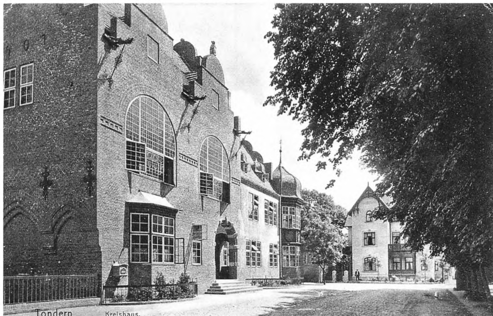
Kredshuset i Tønder blev, da det blev opført 1906-07, en milepæl i udviklingen af en regional arkitektur i Slesvig-Holsten og gav samtidig stødet til oprettelsen af den første Baupflege-forening i provinsen. Illustration: Institut for Sønderjysk Lokalhistorie.
