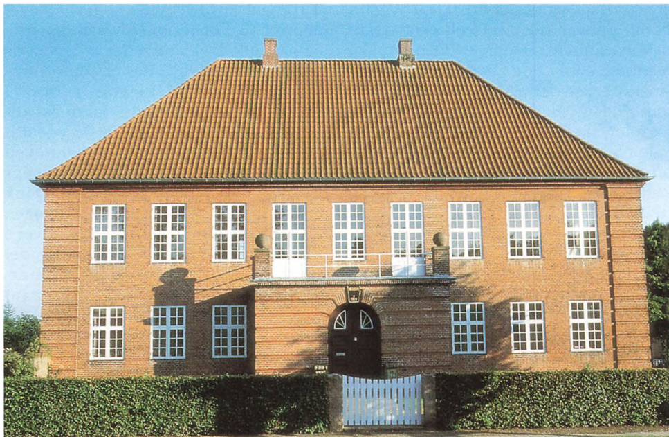
Haderslev Museums gamle hovedbygning ved Åstrupvej, bygget af regeringsbygmester Ernst Hartwig, Berlin, 1914 i en så sønderjysk stil, at den kunne ligge hvor som helst i Danmark. Foto: Peter Dragsbo 2003.
