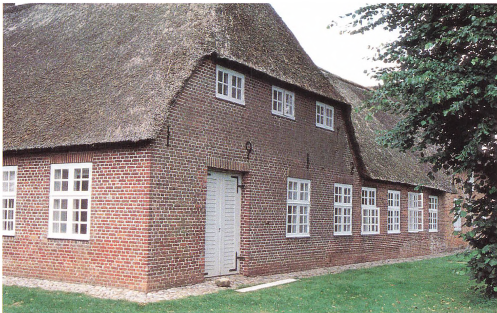
Vinkelvej 18, Rørkær ved Tønder, Brinks gård. Østgavlen med murankrene 1912, som markerer den unge danske arkitekt Kai Gottlobs ombygning af gården. Foto: Peter Dragsbo 2003.
