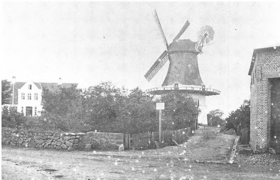
Møllehuset og Højer Mølle med mølledam set fra vejen, den nuværende skolegade, i begyndelsen af århundredet, efter at Højer Mølle var blevet forsynet med selvkrøjeværk. Foto: Højer Lokalhistoriske Arkiv.
