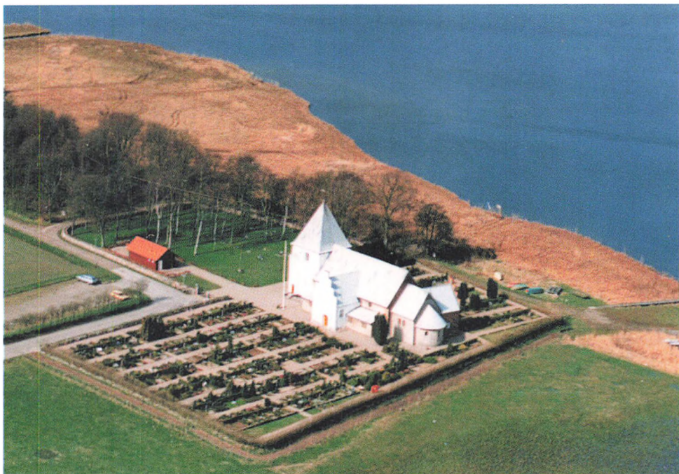
Starup kirke ved Haderslev Fjord er antagelig landsdelens ældste, stående kirkebygning, opført i første halvdel af 1100-tallet af frådsten som et treskibet anlæg. Den fremtræder dog stærkt præget af en hårdhændet, tilbageførende restaurering. Foto: Flyvestation Skrydstrup.
