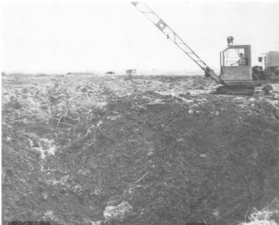
Tørvegravning med gravemaskine i Kongens Mose. Foto: Privat.
