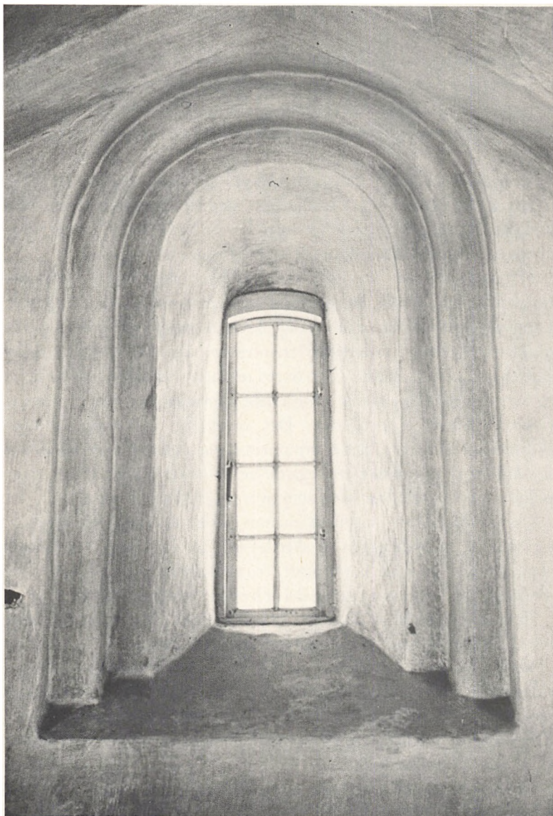
Fig. 13. Korets østvindue set indefra. Medens korets vægge er muret i marksten, er dette fint profilerede vindue muret i teglsten.
