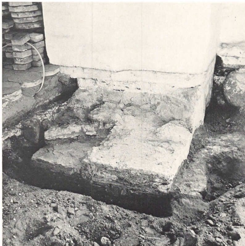
Fig 10. Frådstensfundamentet for den romanske triumfbues sydside. Til venstre i billedet ses rester af korets mørtelgulv. En rest af søndre sidealterbord ses til højre i billedet.
