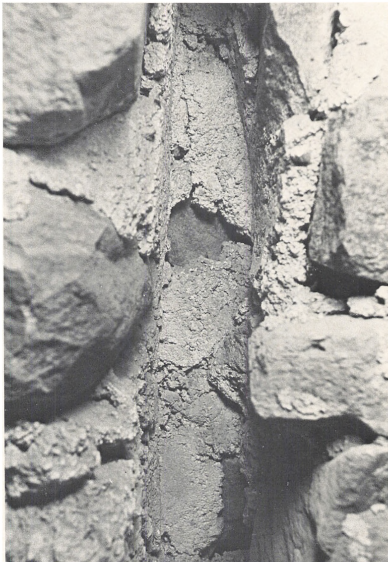
Fig. 31. Spor i triumfmurens østside efter »hammerbånd« fra korets basilikale tagform. Sporene viser, at væggen er muret op omkring »hammerbåndene«.
