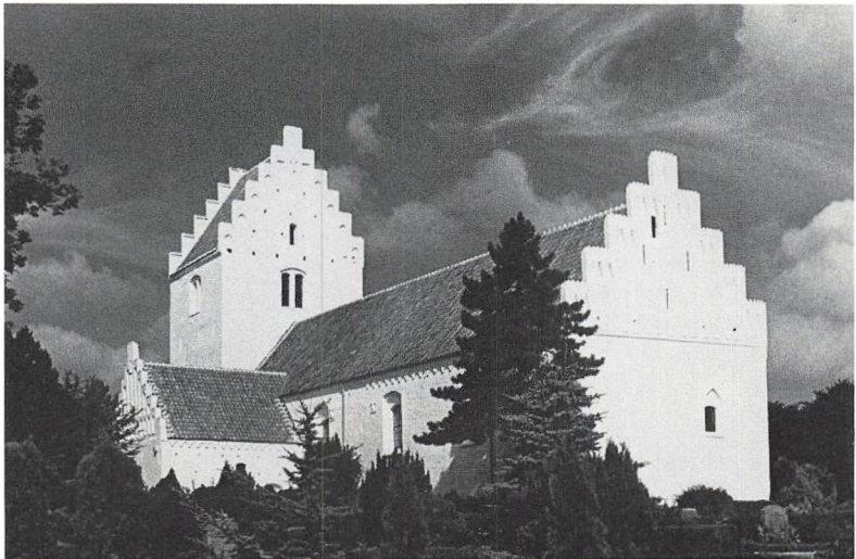
Fig. 15. Kundby kirke i Tuse herred med store fladbuede vinduer i både skib og kor. Korudvidelsen er sket kort efter 1500. I korgavlen et lille fladbuet vindue i spidsbuet spejl. Fladbuede vinduer synes at være anvendt til små åbninger fra ca. 1300, mens større fladbuede vinduer bliver almindelige fra omkring 1400. Bl.a. er Kapitelhuset ved Roskilde domkirkes overetage fra ca. 1400 udstyret med sådanne fladbuede vinduer. De spidsbuede spejle om fladbuede vinduer synes lidt senere; snarest efter 1450 og de er den almindeligste type i klosterbyggeriet fra omkring 1500. Mie Jensen fot.
