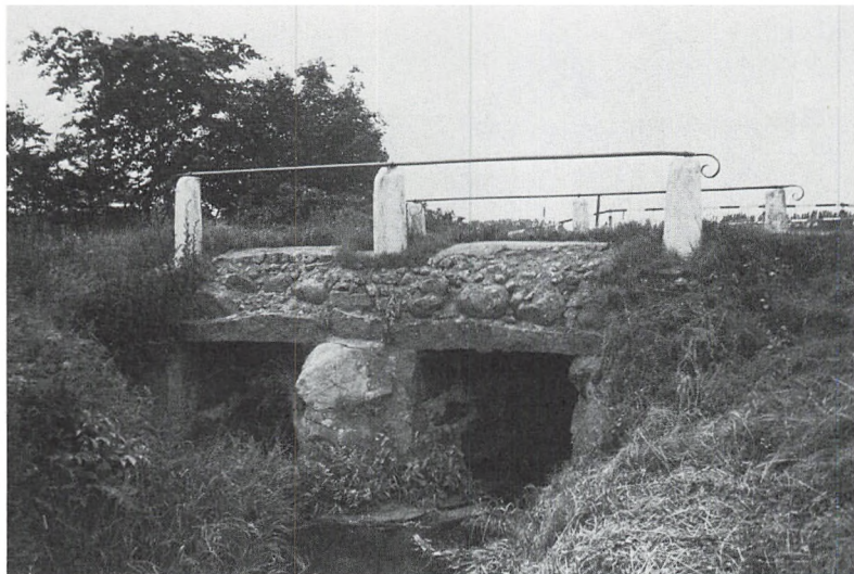
Fig. 2. Butterup bro, opført 1856. Afsløste en brøstfældig træbro. Senest restaureret 1977. Broen ligger med et stykke af den gamle vej på hver side på et afsnøret vejareal. K.-E.H. fot. 1984.
