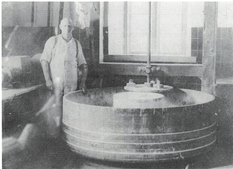
Fig. 7. Rugbrødsæltekar i Egebjerg Mølle. Det blev trukket af en petroleumsmotor, der stod udenfor. I tilfælde af motorstop måtte man ælte med hænderne. Da det var et meget tungt arbejde, og man ofte kom i tidnød, når motoren svigtede, måtte bagersvenden ofte ælte med fødderne. Fra Rørvig understreges det, at man aldrig gik direkte med fødderne i dejen, men strøede mel over dejen og lagde rene sække over, som man trådte på.
