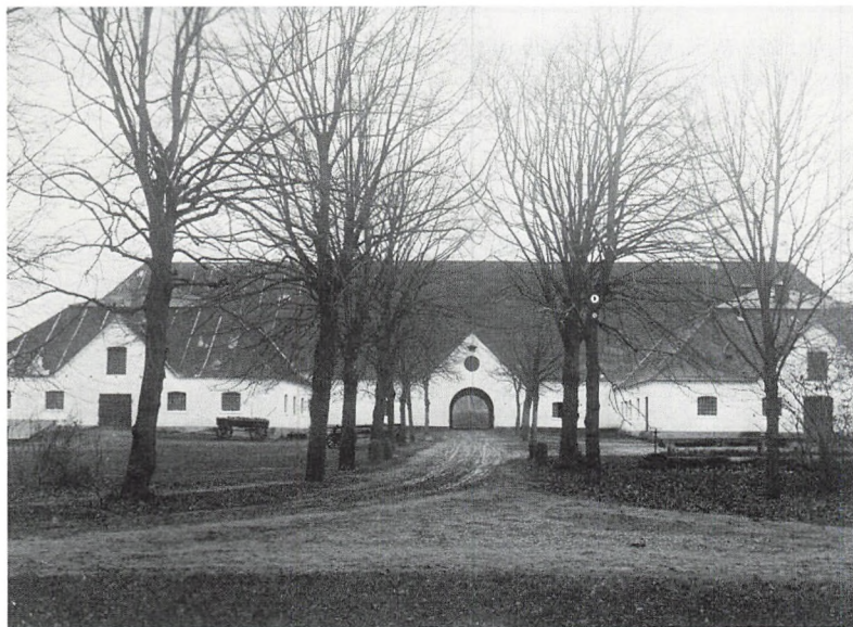
Fig. 6. Gregers Juels ladebygning fra 1707 med de tilbyggede staldbygninger fra 1850'erne. D. Vestergaard, Tølløse, fot.
