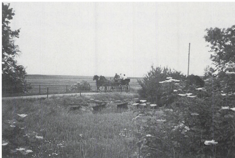
Fig. 4. Bro med 4 gennemløb i udkanten af Nr. Jernløse på Holløse-vejen. Opført 1829. I licitationsbetingelserne for denne bro nævnes specielt, at der ikke må benyttes sten, som er hentet fra gamle kæmpebøje eller andre mindesmærker fra oldtiden. K.-E.H. fot. 1984.
