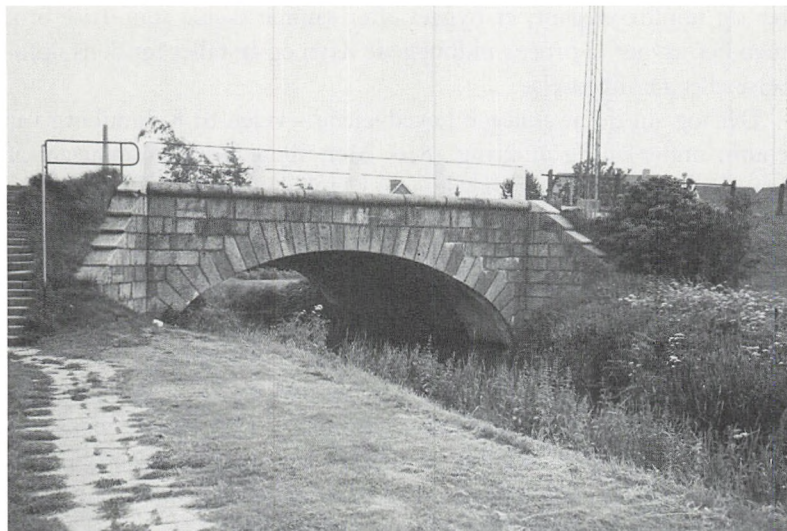
Fig. 5. Svinninge bro, opført 1806-1807. Løjtnant Krebs, som varetog den daglige ledelse af brobygningsarbejdet, havde dårligt forhold både til arbejderne og økonomien. Han blev dømt til at betale bøde for at have fornærmet og slået nogle arbejdere, ligesom han også blev dømt et par hundrede rigsdaler i bøde for uorden i regnskaberne. K.-E.H. fot. 1984.
