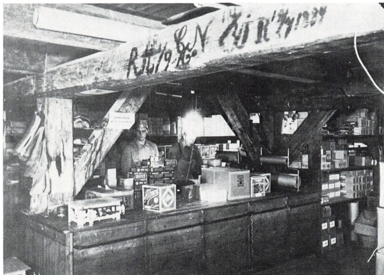
Fig. 6. De store mængder korn behøvede megen plads og vejede godt. Kornmagasinerne krævede svært tømmer som her i Søren Winthers gård (Smedelundsgade). Billedet er taget ca. 1944, så i stedet for kornet er kun erstatningsvarerne i ekspeditionen. (Lokalhistorisk Arkiv for Holbæk kommune)
