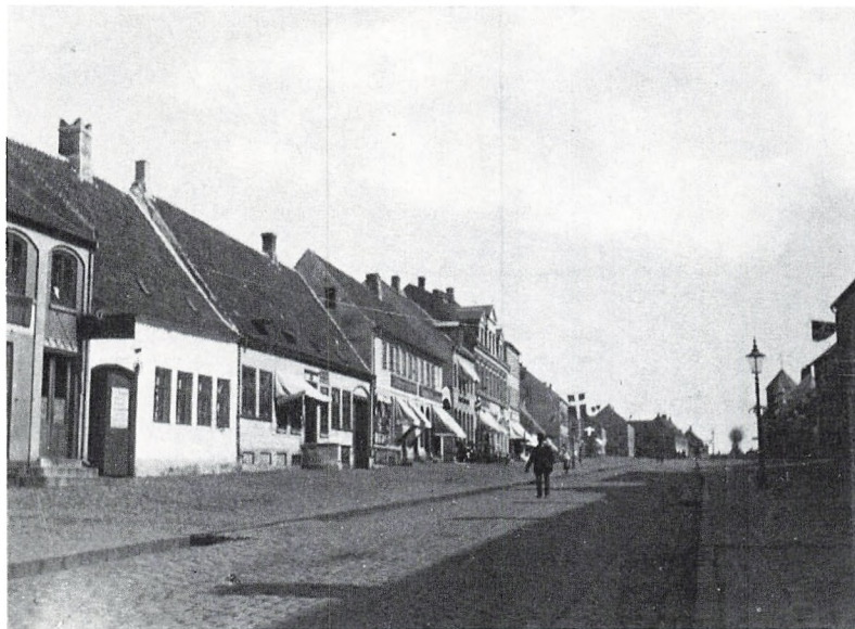
Fig. 14. Ablgade fra nr. 19 og opefter. Bødkerens bus og bageriet er stadig i en etage, men længere oppe er nye og højere bygninger skudt op. (Lokalhistorisk Arkiv for Holbæk kommune)
