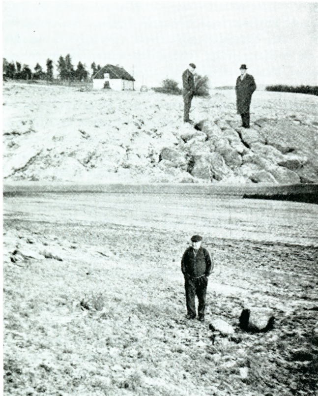
Fot. jan. -61. Her har den gamle Moselund gård ligget fra arilds tid. I plojfurterne findes munkesten og rester af syldesten. I fordybningen ser man det øverste af de mægtige kampesten, som angav gårdens vandforsyning, og Würtz, som bor i længen i baggrunden, den sidste rest af Moselund gård
