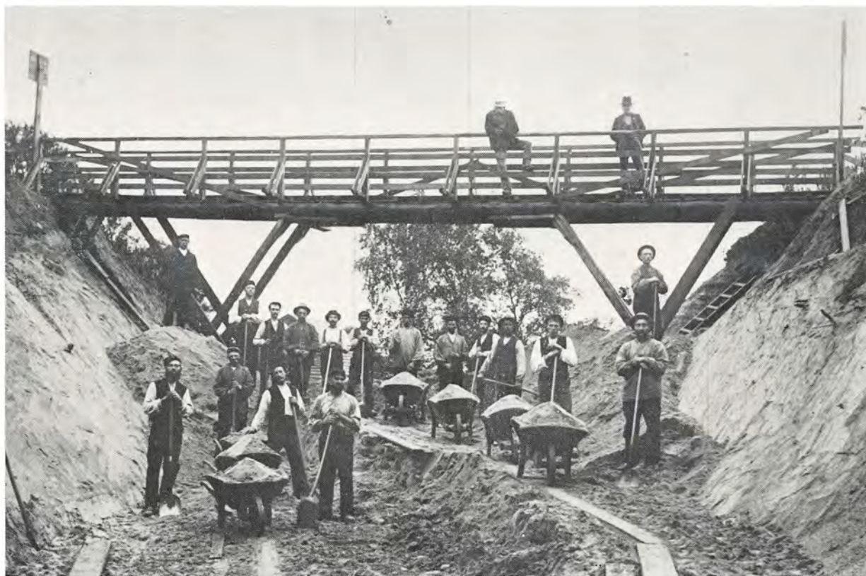
Nr. 161. En stor kloakledning blev i 1903 lagt ud i Lillebælt, hvor svovlsyrefabrikken nu ligger. Her graver man igennem Søndervold.
