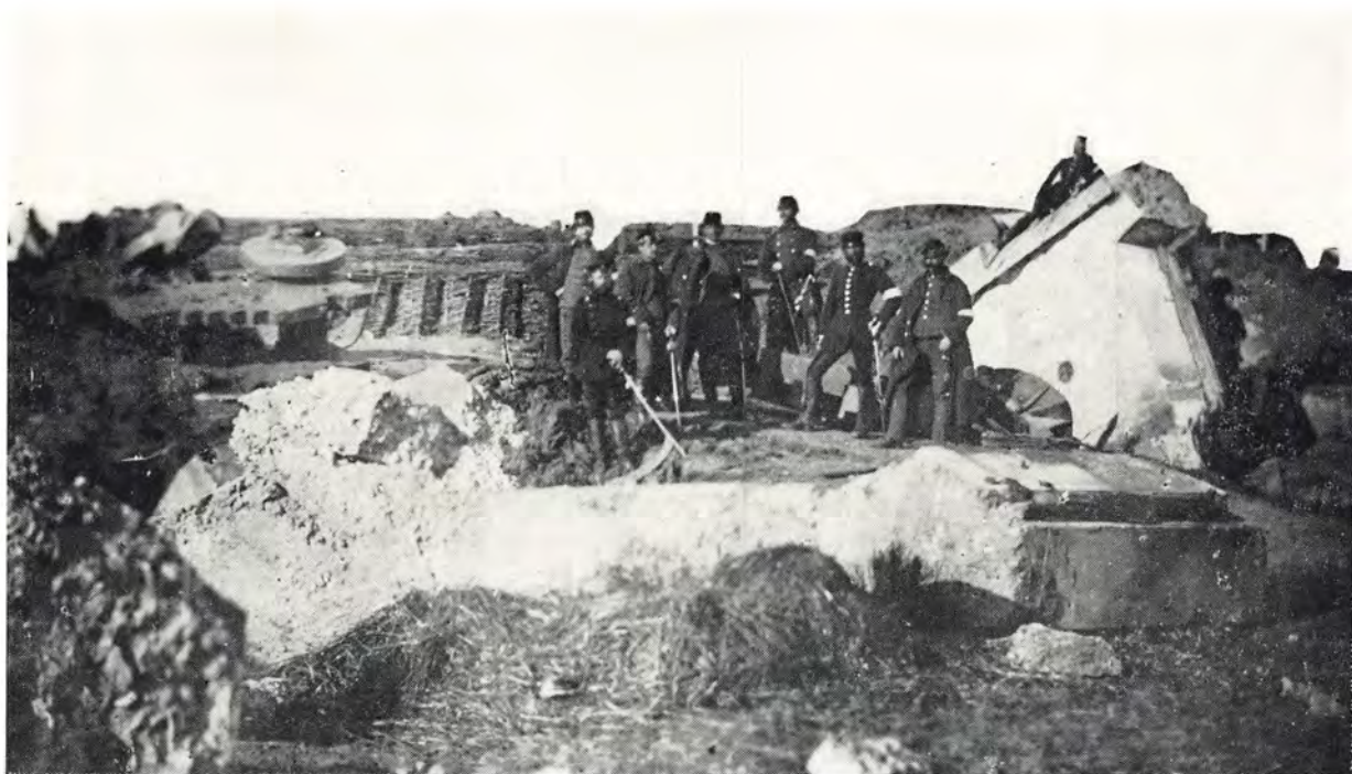
Nr. 36. Skansen efter sprængningen. På billedet ses østrigske soldater.
