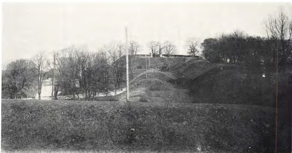
Nr. 101. Udsigt fra Kongens Bastion (udfor Kongensgade) mod øst til Danmarks Bastion, på hvilken man ser Lundings monument. Midt i billedet ses Kongens Port. (Hugo Matthiessens fotografi) 1914.
