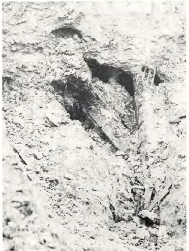
Nr. 83. Ved gennemgravning af volden ved Sjællandsgade fandtes rester af en gammel udfaldsport. På billedet ses gammelt træværk.
