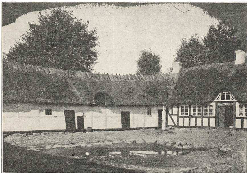
Gammel Sulegaard i Søndersø. (Gaardspladsens nordvestre Hjørne, set fra Porten, med den ældste sulebyggede Vestlænge). (Mogens Clemmensen fot. 1916.)
