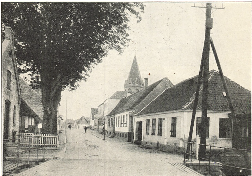
Damgade. Assens. (Fotografier af H. M.)
