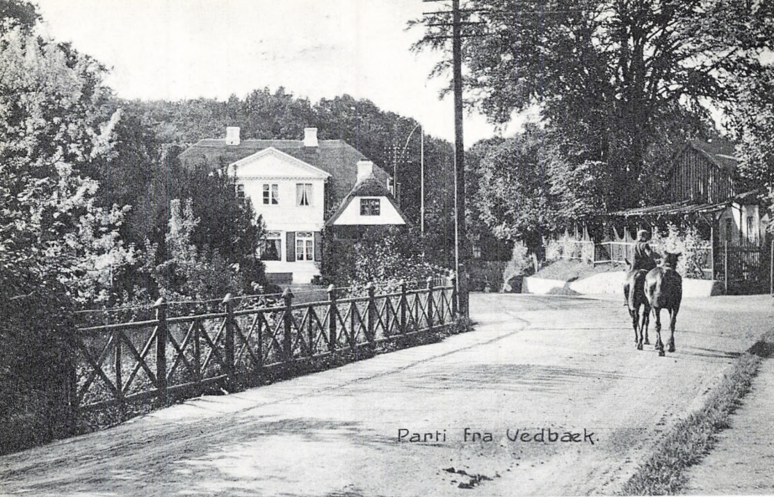
Vedbæk Strandvej ved Villa Egebakken. 1910
