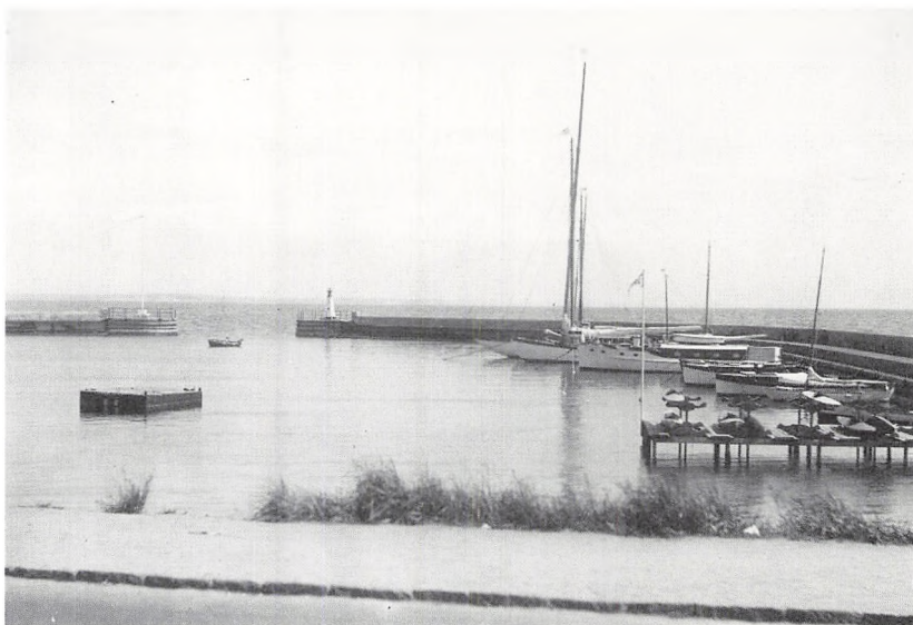
Den beskedne Vedbæk havn omk. 1925 med fyrtårnet, Per Nilens røde øje yderst på molen.
