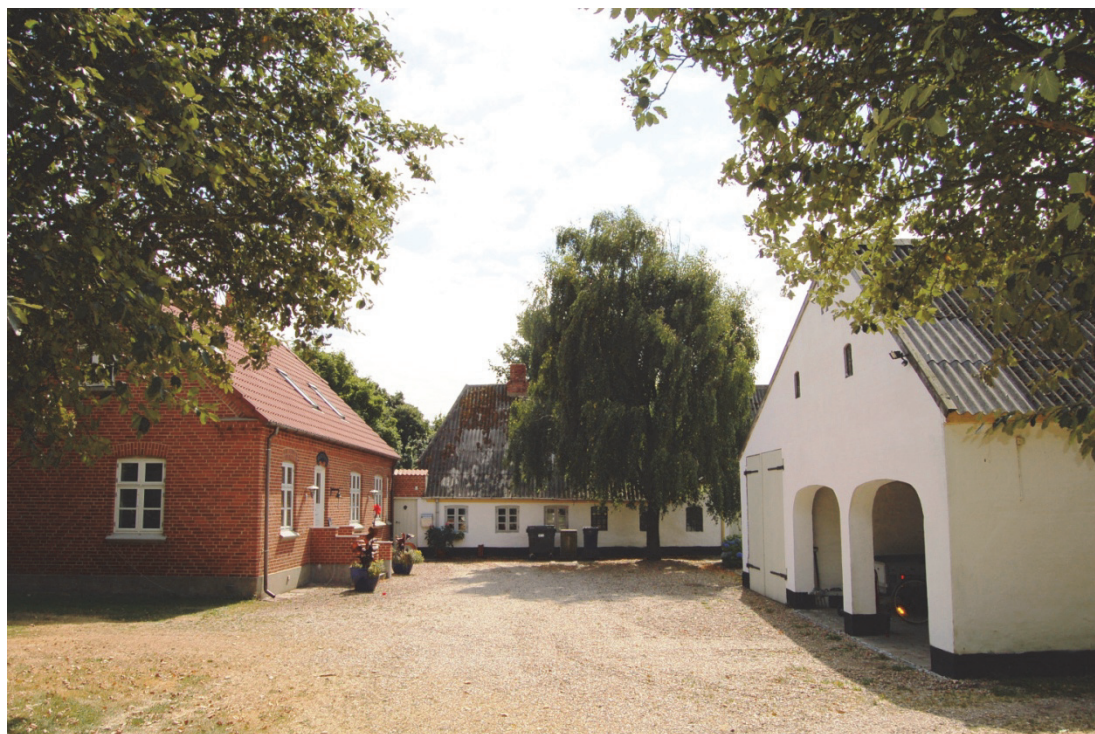
Den gård, der i dag ligger på Sønderbyvej 5 i Tjæreborg, har ingen lighed med den slægtsgård, der var ejet af bl.a. Hans Sillesen og sønnen, Silles Hansen. Der er ingen bygninger tilbage fra den gård, der blev genopbygget efter en brand i 1838 (foto: 2014)
