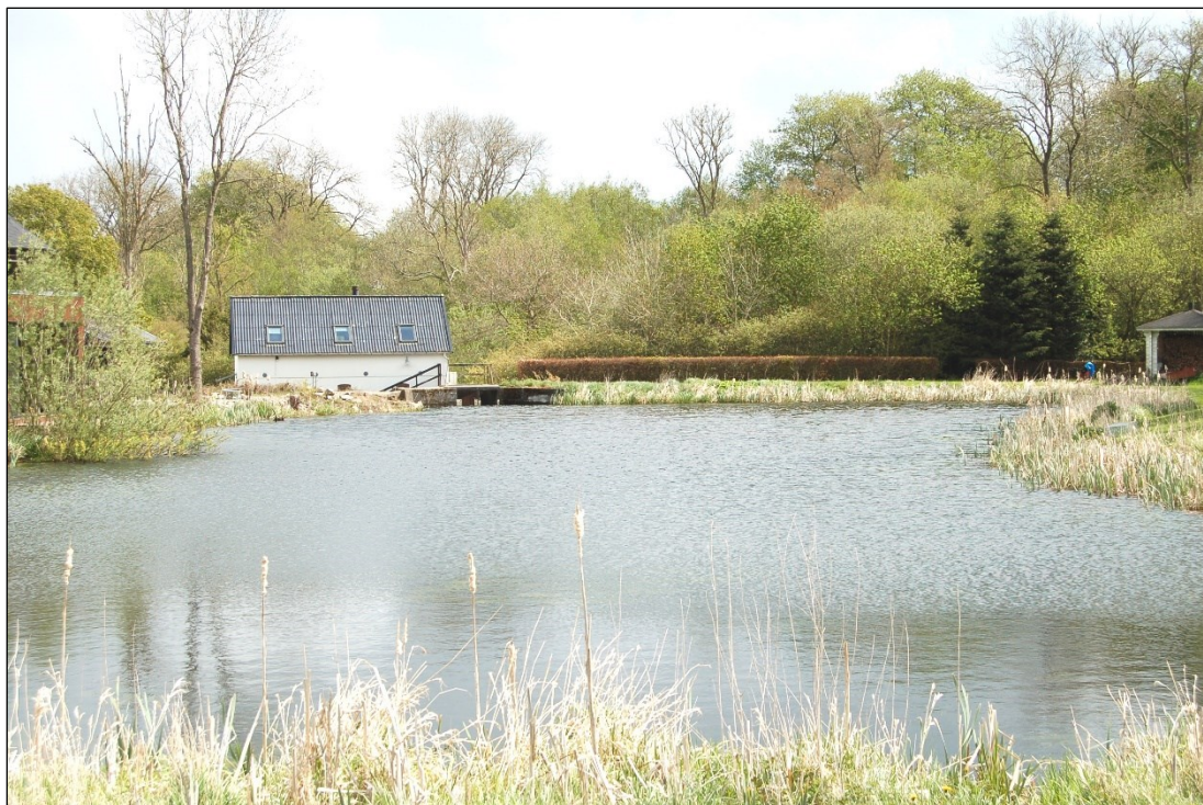
I dag er det kun mølledammen, der er tilbage af Hornborg Mølle. Møllen blev nedlagt ca. 1970. Den maledede korn og havde fire kværne. Møllen var sidst i brug som elektricitetsværk med turbine [3] (foto: 2019)
