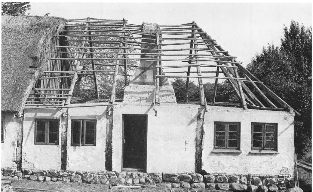
Fig. 22. Efterhånden som huset skilles, kommer overraskelser frem. Her ses f.eks. først rigtig den eneste bevarede af de ældre skorstene. Den er af soltørrede lersten, og den specielle facon skyldes, at piben samler
