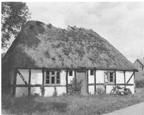
Fig. 58. I 1844 blev dette fattighus opført i Hvornum i Randers amt til ialt fire familier. Hver har et rum med et lille ildsted i forbindelse med den store skorsten midt i huset. Den var faldet ned, da dette billede blev taget i 1963, men da havde huset også stået tomt et par år. Nu afdøde museumsleder Peter Riismøller betegnede i et brev til Frilandsmuseet i 1963 huset som »et typisk jysk fattighus«.
