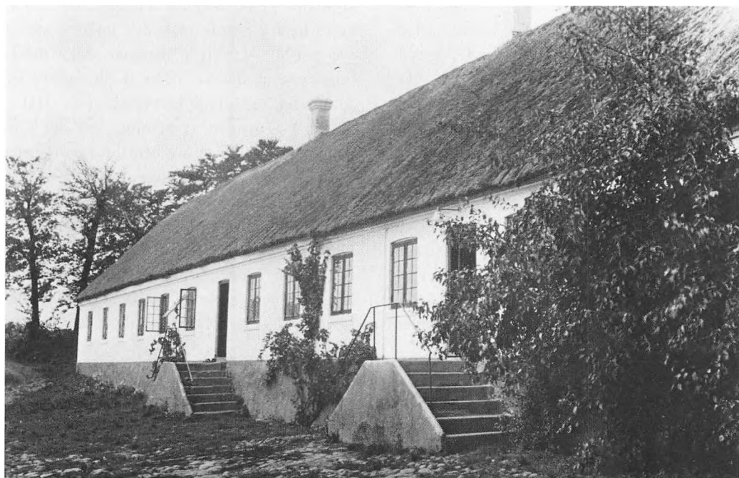
Fig. 65. Stuelængen på Riis Fattiggård set fra gårdsiden. Det meget lange hus er karakteristisk for fattiggårde, og det samme gælder grundplanen med en lang gang midt gennem en del af huset, (her i den fjernere
