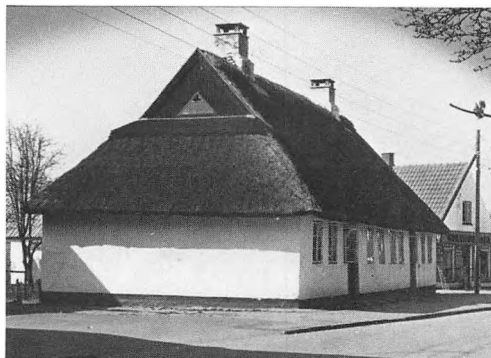
Fig. 56. 1832 byggede ejeren af Gislingegård dette fattighus i Gislinge, mellem Holbæk og Kalundborg. Af gavebrevet fremgår det, at der skulle være 4 stuer med 2 senge i hver og 1 tørverum til hver stue. 2 stuer skulle deles om en skorsten, men selve de 2 arbejdsbænke var helt adskilt. Det vides ikke, hvor meget husets ydre har ændret sig i tiden, indtil dette billede blev taget i 1959.
