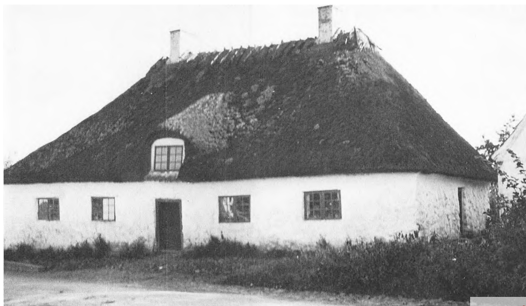
Fig. 46. På Fyn er hospitalerne hyppigt grundmurede, og ofte i kampesten som på billedet af V. Åby Hospital. Der er også en gennemgående grundplan for de fynske hospitaler med 8 værelser, 2 store skorstene med 8 små ildsteder samt 4 indgangsdøre, ganske som i planen over Katterød Hospital, fig. 47. – V. Åby Hospital blev oprettet i 1794 til 8 familier fra V. Åby sogn ved Fåborg. (fot. 1921).
